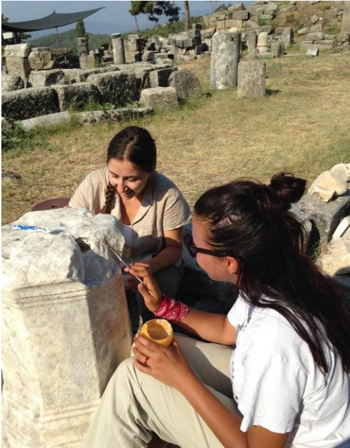
Lagning av sprickor med kalkbruk görs av studenterna som deltar i projektet 2017.
