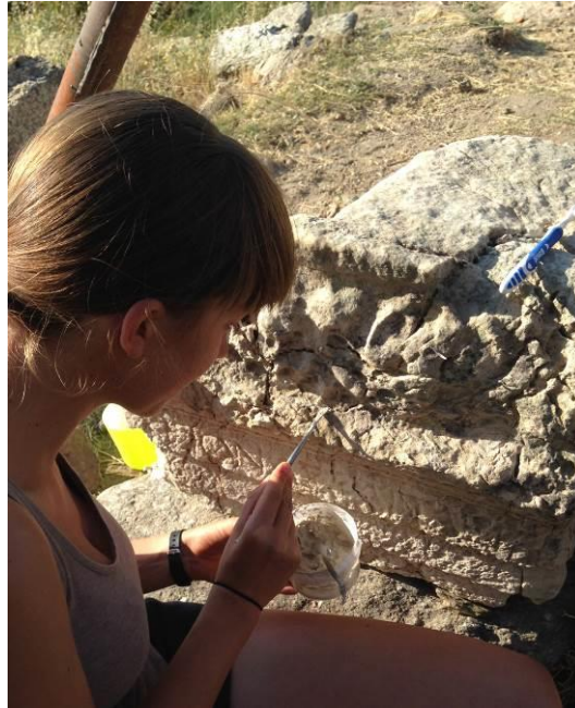
Lagning av sprickor med kalkbruk görs av studenterna som deltar i projektet 2017.
